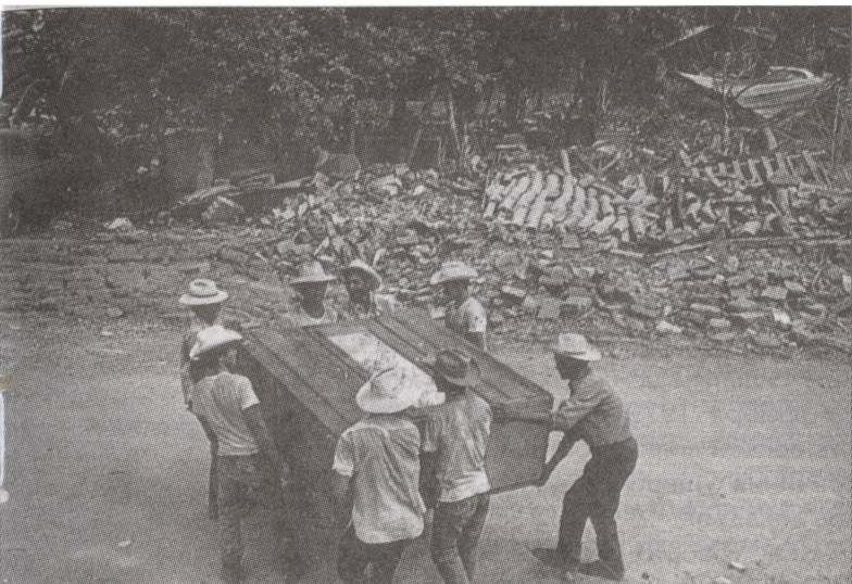
Последствия землетрясения в Гватемале. 1976 г.
