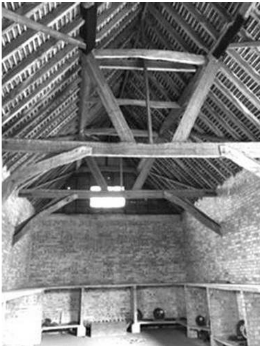
Внешне деревянный амбар «Гибралтар», внутри которого – кирпичная кладка и бетонные перекрытия.
